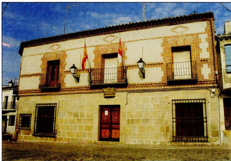
La Calzada de Oropesa: Fachada de las Casas Consistoriales, con adornos mudéjares.
